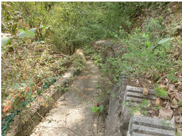
산마루측구, 점검계단 전경
