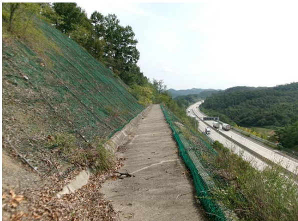
1소단 배수로 전경
