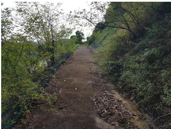
1소단 배수로 전경
