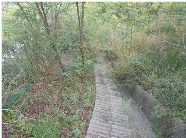
산마루측구, 점검계단 전경
