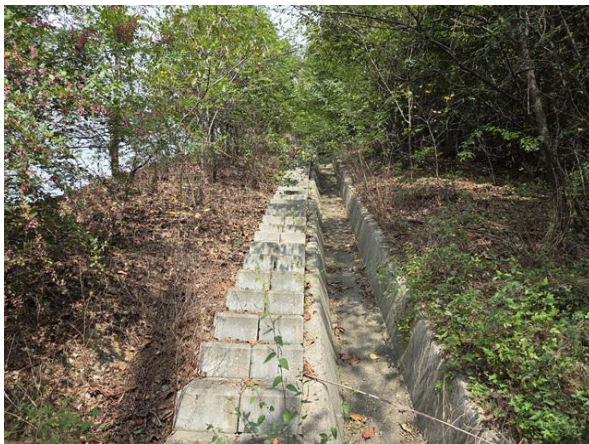
산마루측구, 점검계단 전경
