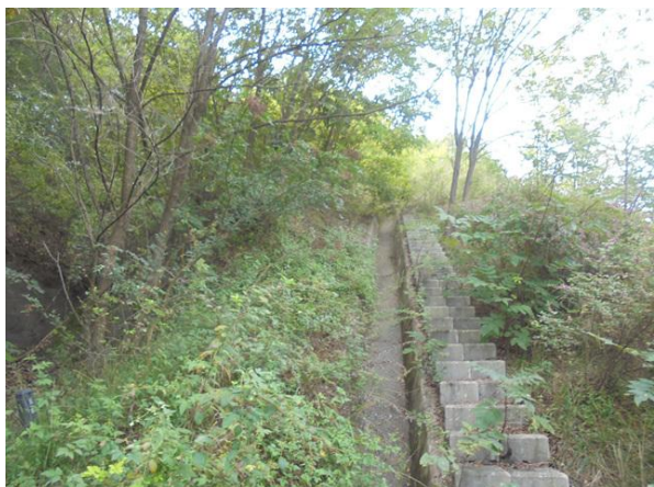
산마루측구, 점검계단 전경
