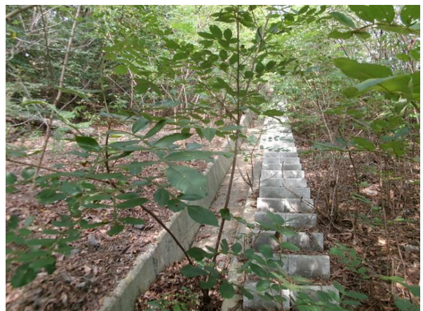
산마루측구, 점검계단 전경
