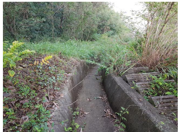
점검계단, 산마루측구 전경
