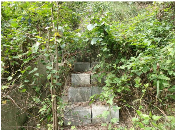
산마루측구, 점검계단 전경
